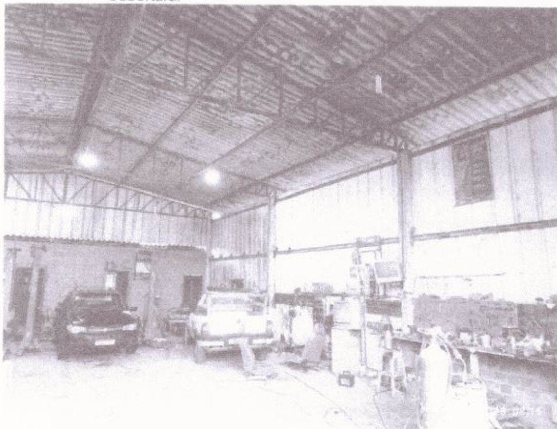
Figura 03 – Visualização dos bens cedidos: Pilares, Tesouras, Terças e Cobertura.
