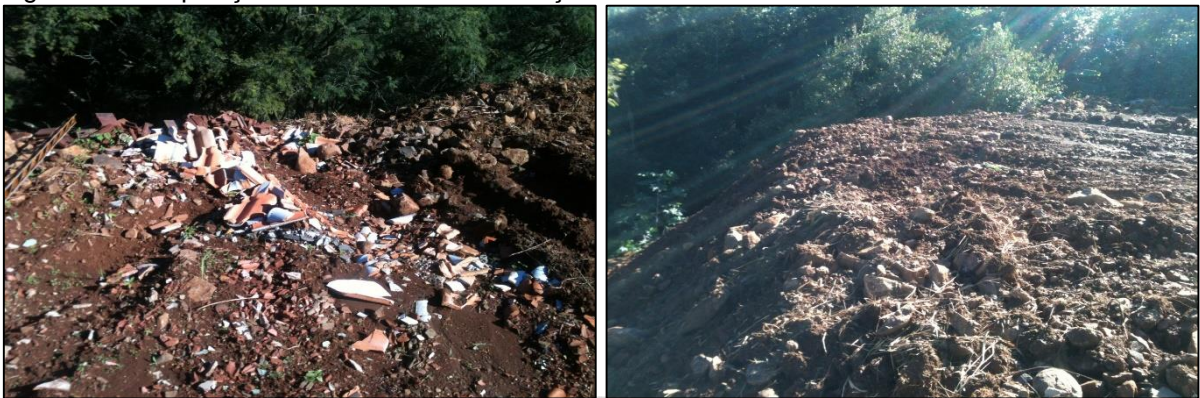
Figura 85 – Disposição de resíduos da construção civil em Cunhataí
