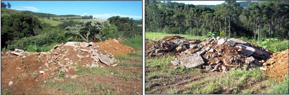
Figura 92 – Local de disposição dos resíduos da construção civil em Saltinho
