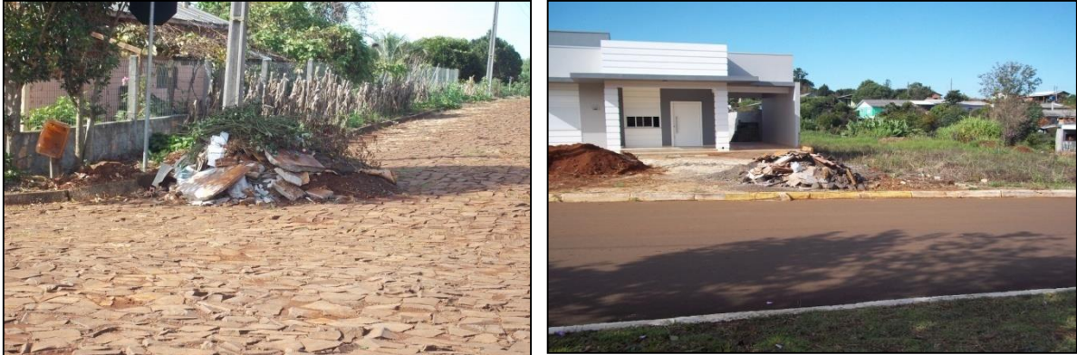
Figura 81 – Disposição de resíduos da construção civil em vias públicas
