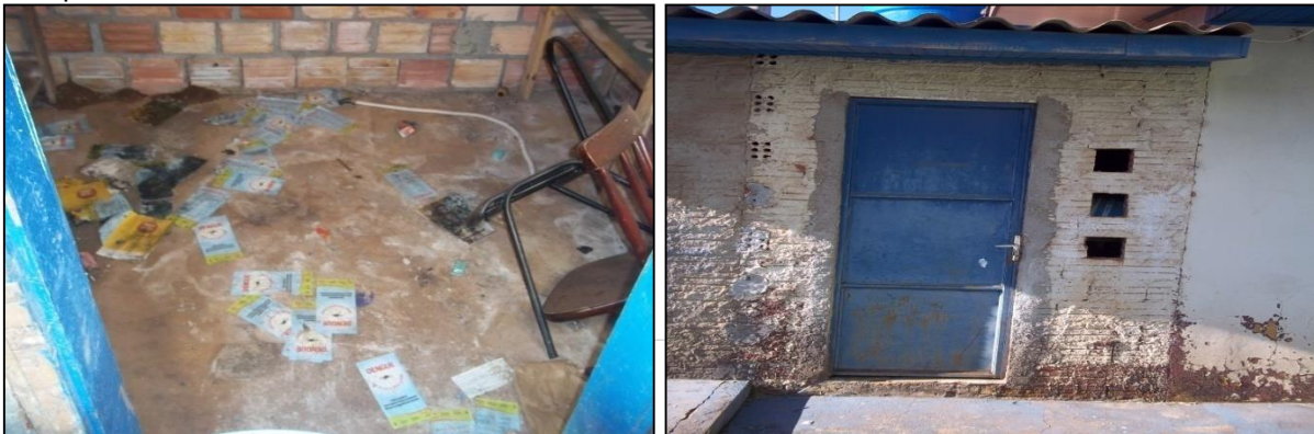
Figura 98 – Local de acondicionamento dos resíduos do serviço da saúde unidade Centro em Campo Erê
