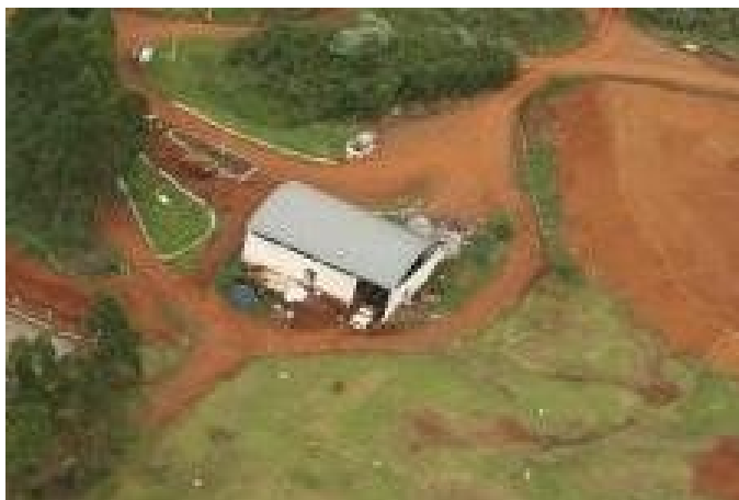
Figura 6.16 - Vista do Centro de Valorização de Materiais Recicláveis (Fonte Tucano)
