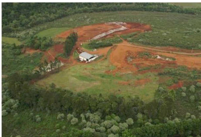
Figura 6.10 - Vista aérea da área do aterro (Fonte Tucano)
