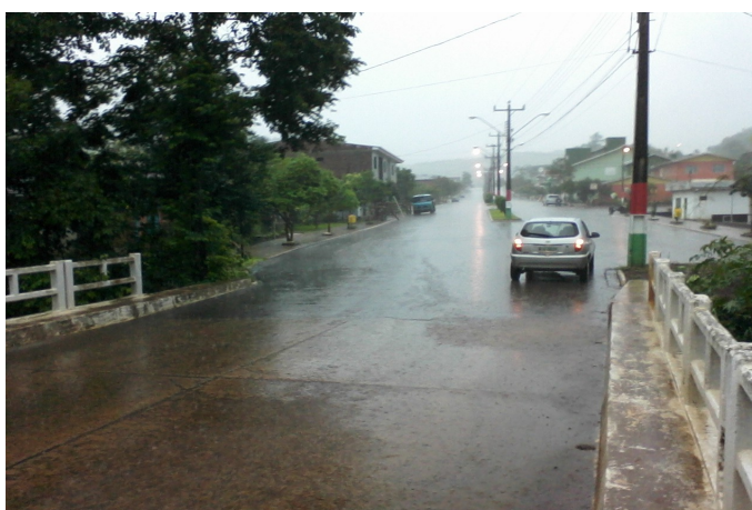
Figura 5.2: Drenagem urbana com residências nas margens
