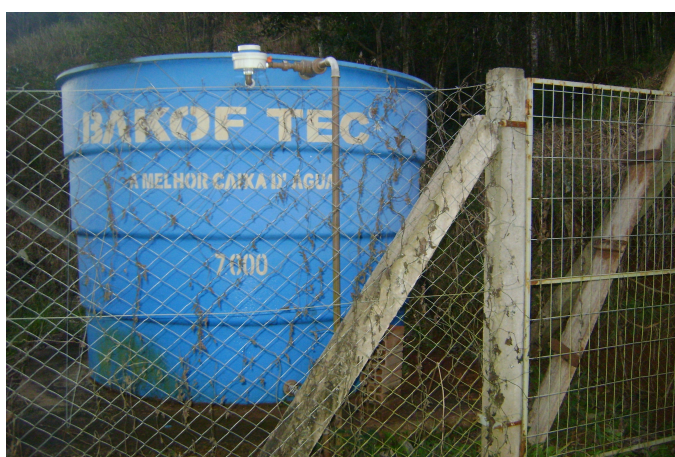
Figura 4.22: Reservatório de Linha Sarandi
