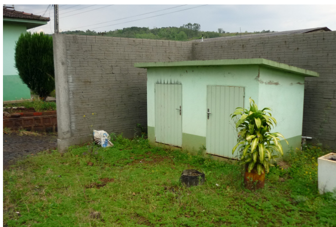
Figura 6.5: Depósito temporário de resíduos.
