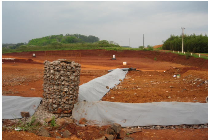
Figura 6.8 - Sistema de drenagem de gases (Fonte Tucano)
