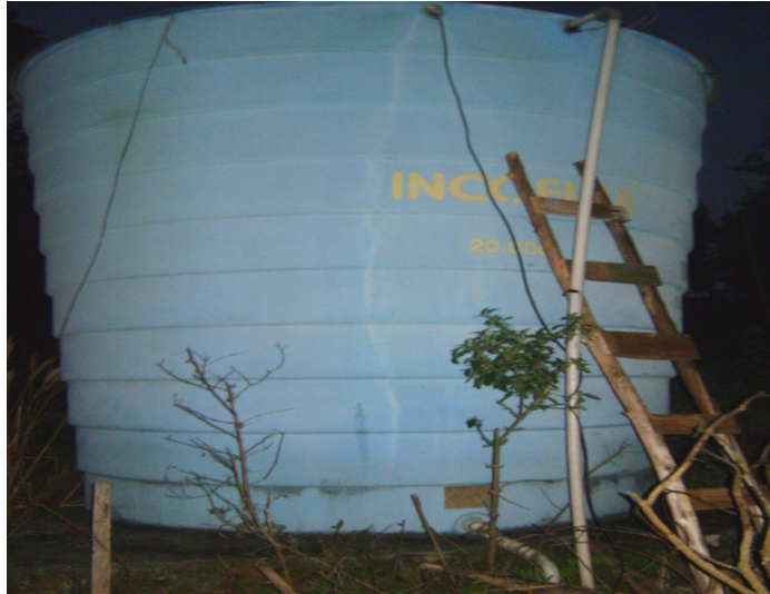
Figura 4.7:Reservatórios 2 situado no poço profundo Flor do Sertão 2.
