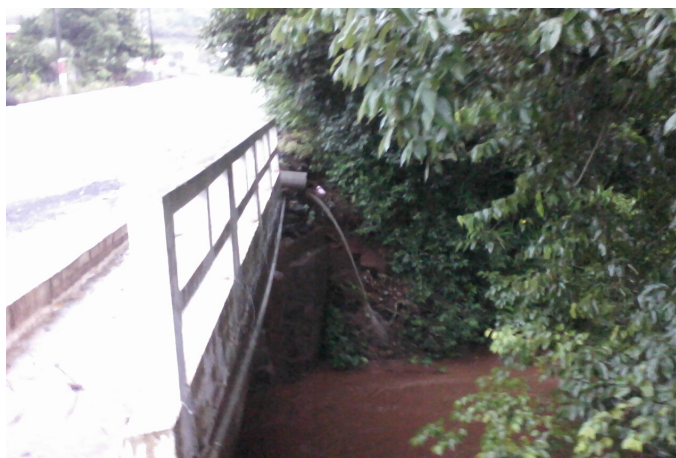
Figura 5.3: Saída da drenagem para o córrego
