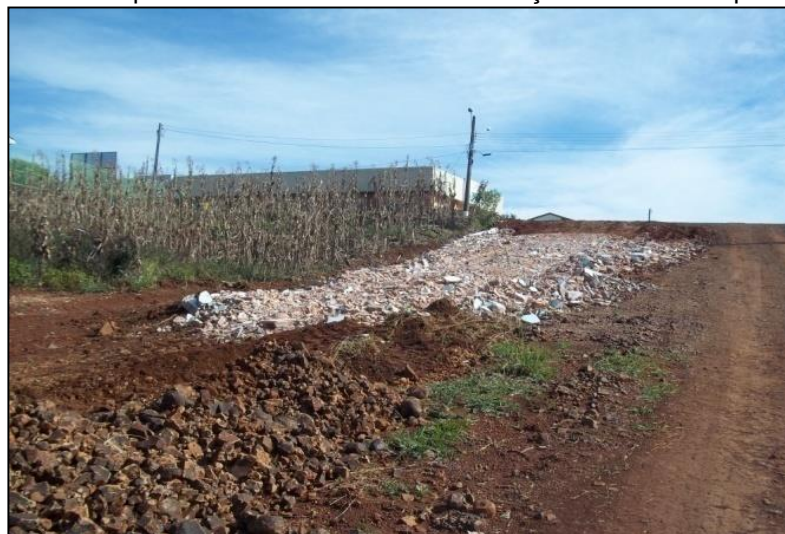
Figura 82 – Aterramento de vias públicas com resíduos da construção civil em Campo Erê
