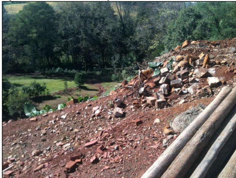
Figura 80 – Disposição de resíduos da construção civil em Caibi
