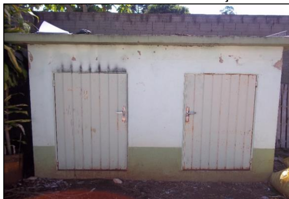
Figura 102 – Local de acondicionamento dos resíduos do serviço da saúde em Flor do Sertão
