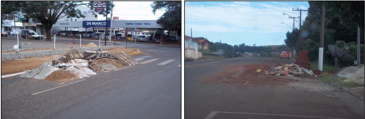
Figura 87 – Armazenamento de resíduos da construção civil em vias públicas em Maravilha
