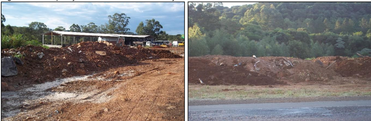
Figura 84 – Disposição de resíduos da construção civil em Cunha Porã
