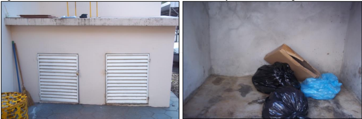
Figura 117 – Local de acondicionamento dos resíduos do serviço da saúde em Tigrinhos
