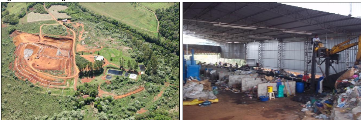
Figura 122 – Imagens do Aterro Sanitário da TOS Ambiental - Saudades
